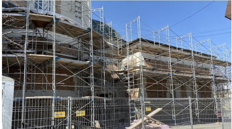
« Cette année, on va faire la restauration de la façade nord. On a installé des échafaudages au niveau de la sacristie, de la chapelle Sacré-Cœur et ça va monter jusqu'au couronnement du dôme. On va réparer aussi les tôles de cuivre sur le toit pour éviter les infiltrations d'eau comme ce qui se passe en haut du baptistère, a expliqué Pierre Roch, président de la Fabrique et chargé de projet. »
